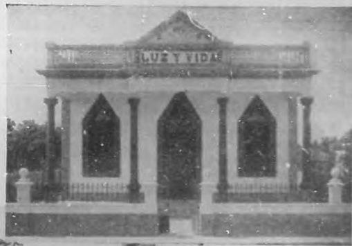
DE MANICAS.—Nuevo edificio de la "Luz y Vida", de la que son miembros, por distintos elementos de esta prestigiosa publicación. Arriba, edificio que inauguró recientemente en brillante acto.
